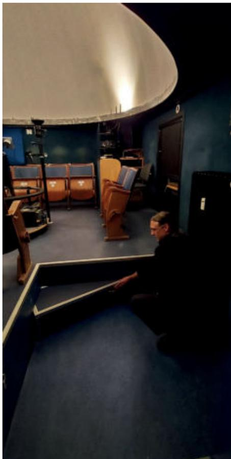
Die Stufe ist nun mechanisch sehr leichtgängig unter dem Podest versenkbar. Dadurch entsteht ein neuer vollwertiger und ebenerdig zugänglicher Publikumsplatz.
